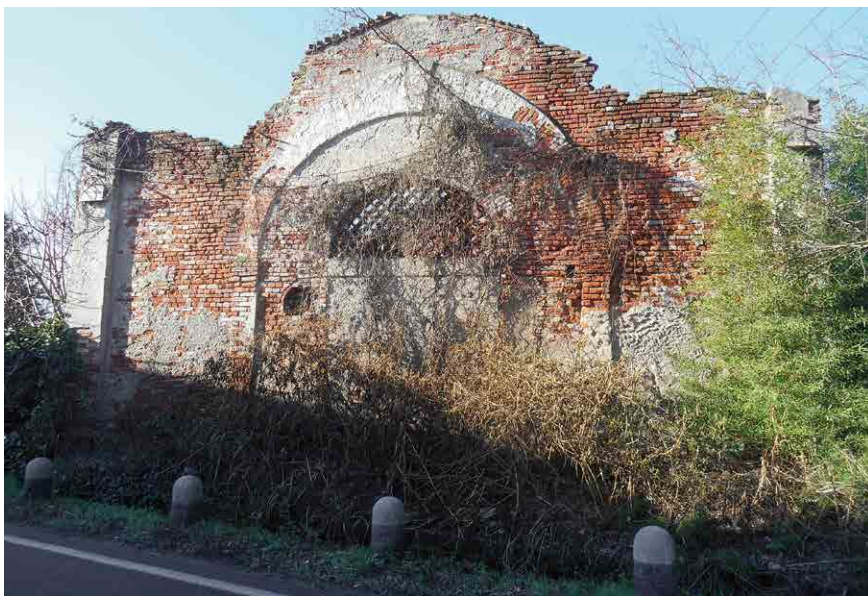
Cascina a Chiaravalle: l'ultimo stadio di degrado: la parete che resta ancora in piedi, minaccia la strada.
