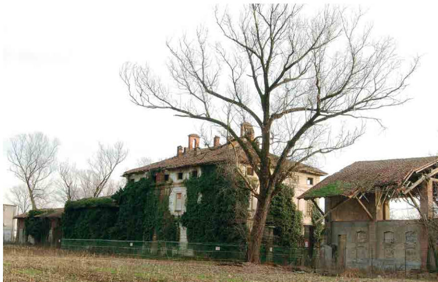
Cascina Camposoglio a Pioltello. (Milano). Risale al XVIII secolo, ai confini dell'area protetta del Bosco della Besozza; è ormai in stato di completo abbandono. La meravigliosa casa padronale oggi è un immondezzato a cielo aperto.
