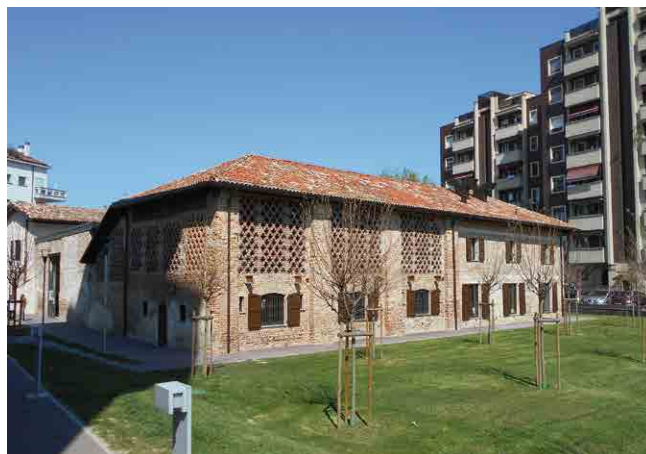
Cascina Torrette, la relazione con i palazzi del quartiere
