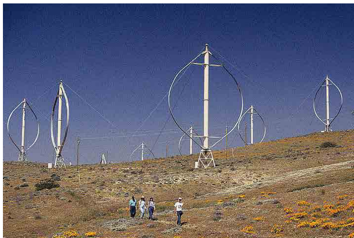
Turbina ad asse verticale di grande taglia
