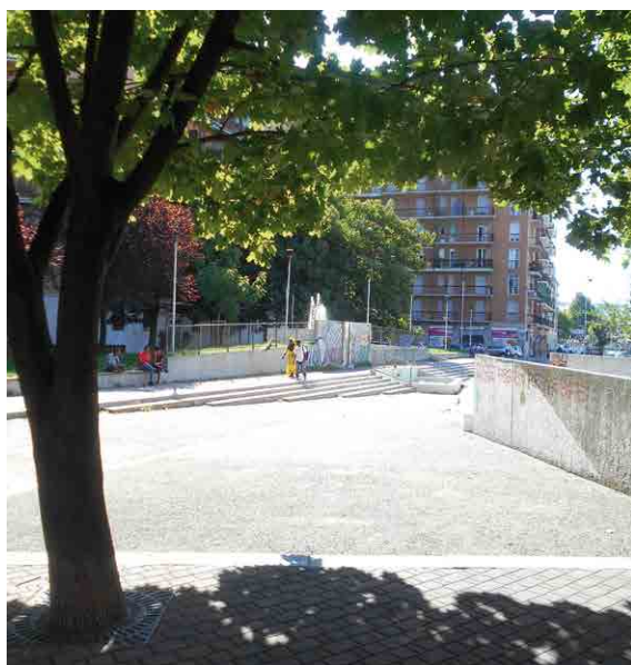
7. Milano, Piazza Schiavone così come appare oggi. Dopo le proteste dei residenti, il grande diaframma di cemento è stato parzialmente abbattuto e sostituito da una balaustra in ferro e da una seduta molto più bassa del muro originario. Rimane la divisione della piazza in parte dura e parte morbida.
