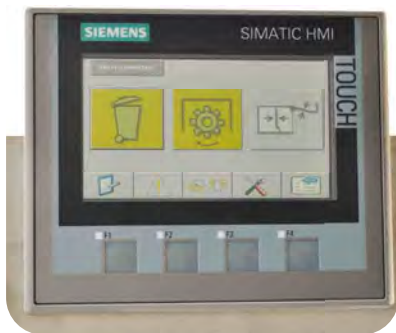
Quadro di controllo SIEMENS con sistema PROFINET
