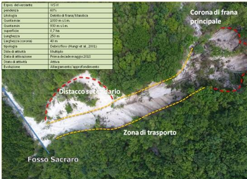
Figura 2: Corona principale, zona di trasporto e di scorrimento del fenomeno franoso che ha provocato nel maggio '18 il danneggiamento e l'interruzione del sentiero E4
