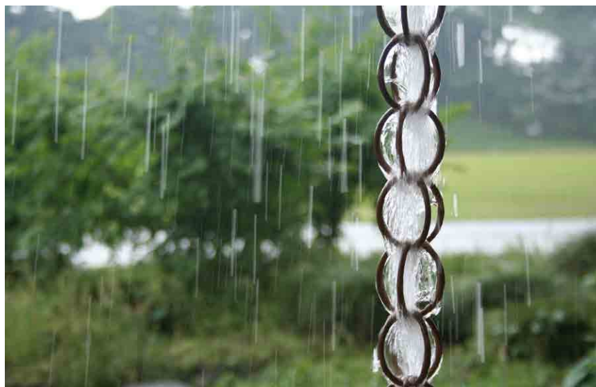
Catene della pioggia (Rain chain): non grondaie o tubature nascoste, ma oggetti decorativi e musicali che guidano la pioggia dal tetto dell'edificio verso il terreno.
