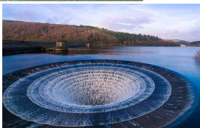
Sfioratore "Glory hole", diga di Monticello, California
